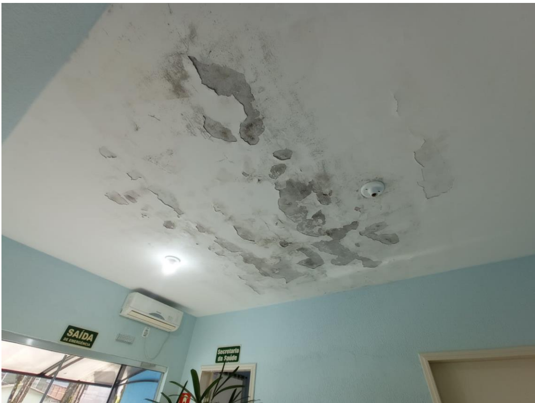
Imagem 16: Revestimento de laje em área interna
